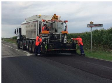
Mandatée par le Département, la société VIAFRANCE a procédé au renouvellement de la couche de roulement de la route de Pont de l'Arche. Un enrobé coulé à froid a été répandu sur la chaussée afin de pérenniser l'étanchéité de la voie de circulation.
