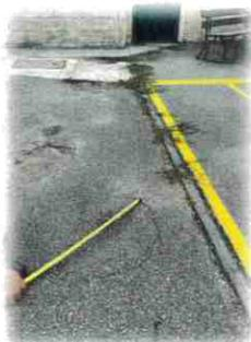
Fort heureusement, la conclusion du bureau d'étude stipule que l'origine de cet affaissement proviendrait d'un drainage involontaire des eaux pluviales par un ancien fourreau.
