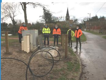
L'installation d'un poste de refoulement d'eaux pluviales équipé de deux pompes submersibles de 20m<sup>3</sup>/h et la pose d'environ 340mL de tuyau en polyéthylène haute densité 110mm ont été réalisées au cours du deuxième semestre de l'année. L'investissement d'environ 100 000 € devrait être rentabilisé sur environ 6,5 années.
