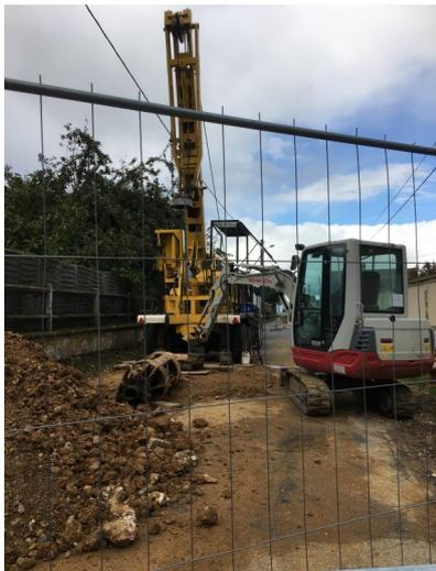
Après avoir réalisé sur la chaussée un puits et six sondages, le bureau d'étude GINGER a remis mi-décembre son diagnostic au Département. Au regard de l'inspection vidéo, il est observé trois niveaux de cavités variant entre -17m et -24m avec la présence d'éboulis. Dans sa conclusion, le bureau d'étude préconise de poursuivre les investigations en menant une deuxième campagne de sondages.
